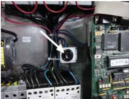
Bild 4: Taster für Referenzpunkt
